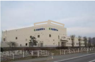
米粉製粉工場
