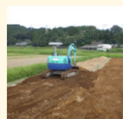
土層改良（客土）
