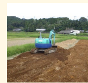
土層改良 (客土)
