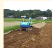
土層改良(客土)
