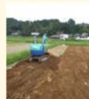
土層改良（客土）
