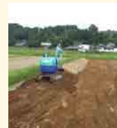
土層改良（客土）
