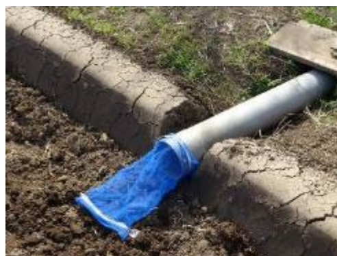
取水口への網の設置
