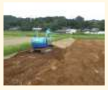
土層改良（客土）
