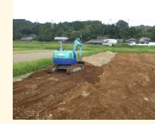
土層改良（客土）
