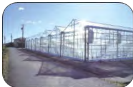
鉄骨ハウス（ポリオレフィン系・その他プラスチックフィルム）
