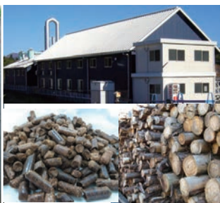
木質ペレット工場
