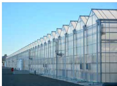
高軒高多連棟ハウス
