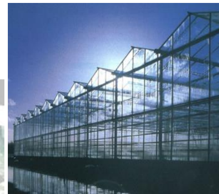
フェンロー温室
