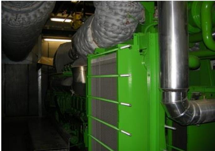
天然ガスエンジンにより、熱、電気、CO<sub>2</sub>を利用するトリジェネレーションシステムを導入。
