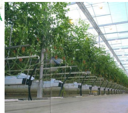
トマト栽培設備
