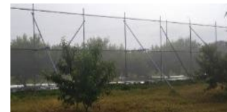
防風ネットの設置
