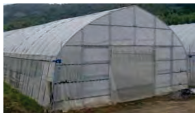
パイプハウス
