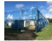
防風ネットの設置
