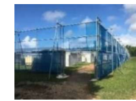
防風ネットの設置
