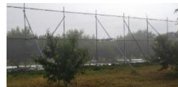
防風ネットの設置
