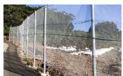
防風ネットの設置（みかんの例）
