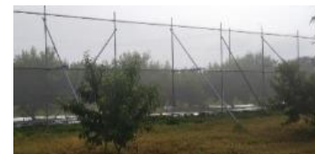
防風ネットの設置
