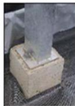
ソイルセメントを用いた基礎部の補強
