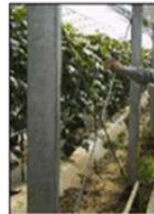
ブレースの増設
