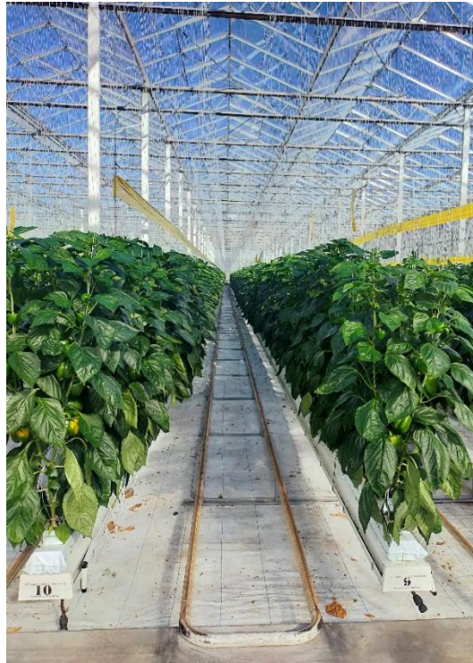
パイプレール式温湯設備 出所：植物工場研究会撮影
