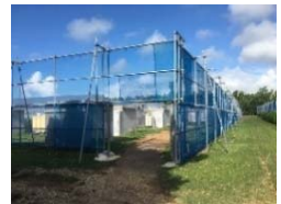
防風ネットの設置
