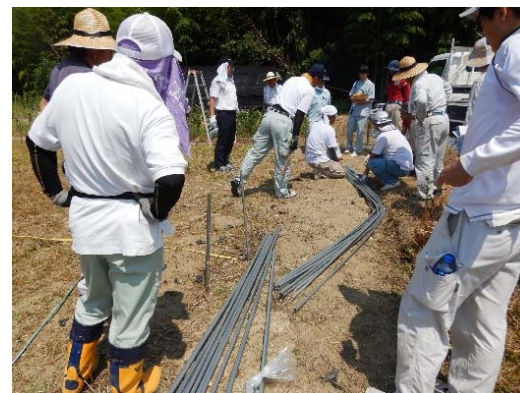
災害復旧の取組実証
