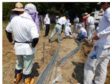
災害復旧の取組実証
