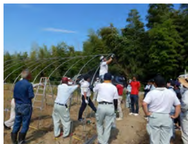
自力施工講習会
