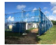
防風ネットの設置
