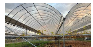
簡易雨よけ設備
