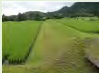
(緩傾斜化された斜面)
