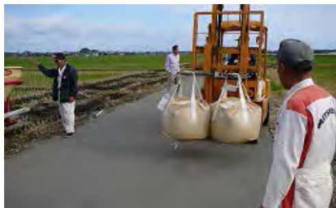
フレコン資材の散布作業
