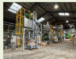
← 補助事業で導入した堆肥化施設
