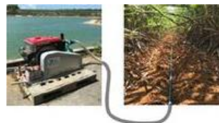
遠隔操作による かん水ポンプの起動
