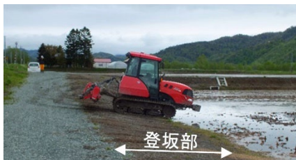
農道ターン方式の機能を有する農道
