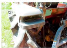
リヤランプ破損
