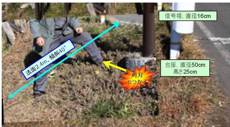
道路際で、色々な構造物があり、作業性の悪い所。なおかつ、傾斜が40°とかなりきつく不安定。信号塔の台座に刃がぶつかり、左足にキックバック
