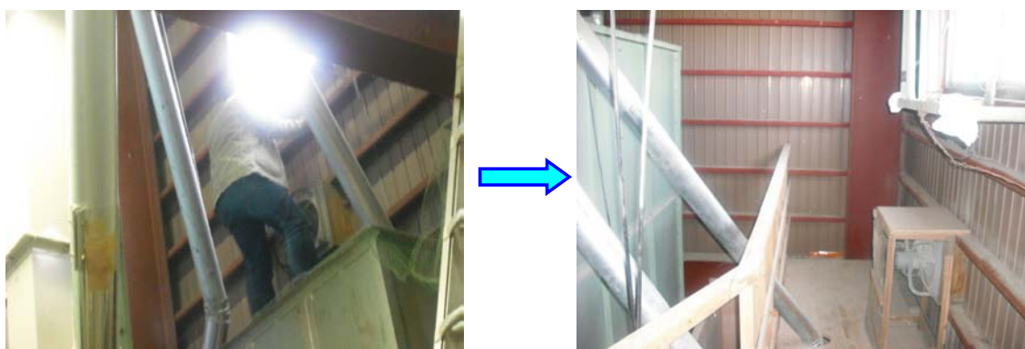
窓を開けるため、左図のごとく鉄骨を伝って落下、事故後右図のごとく通路を設置
