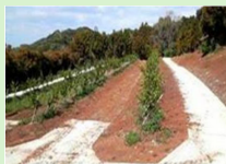
園内道の整備
