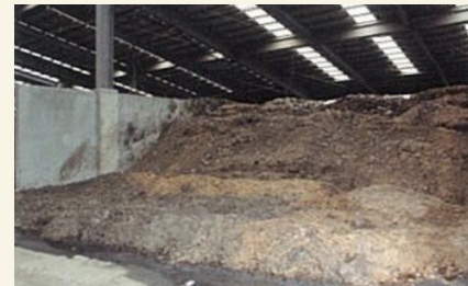
既存の用土等供給施設
