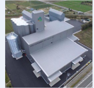
再編集約化後の新設施設
