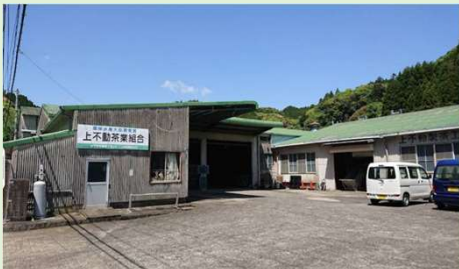
解体・撤去する茶工場
