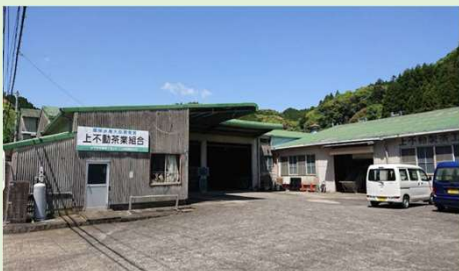
解体・撤去する茶工場
