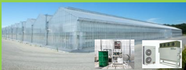
CO 2 貯留・供給装置 ヒートポンプ
