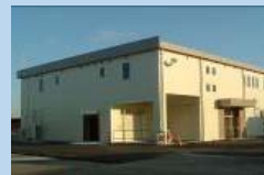
▲ 集出荷貯蔵施設
