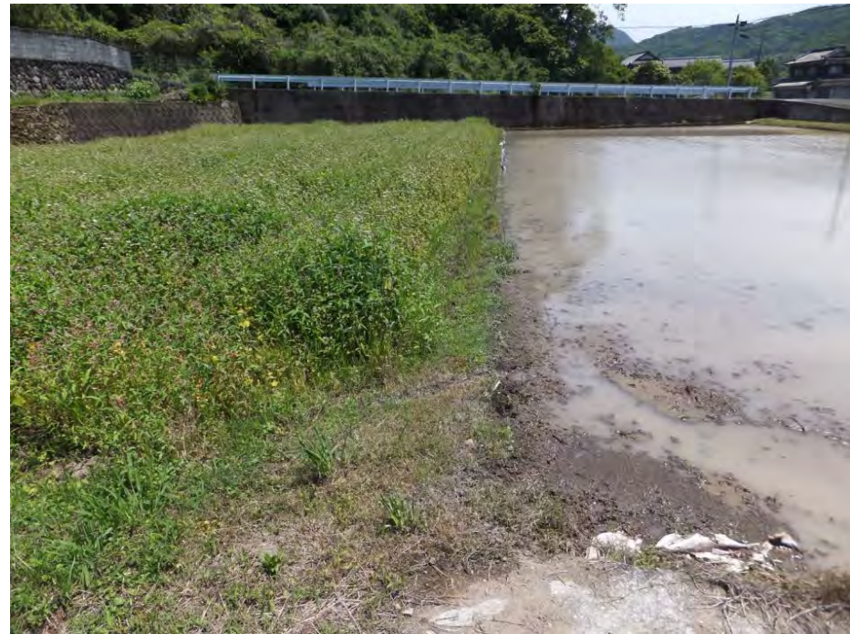
隣接水田からの漏水
