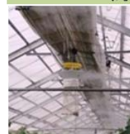
細霧冷房装置の設置
