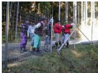
侵入防止柵の設置
