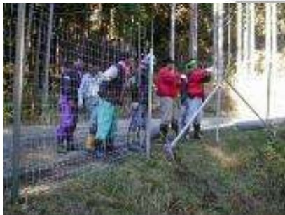
侵入防止柵の設置
