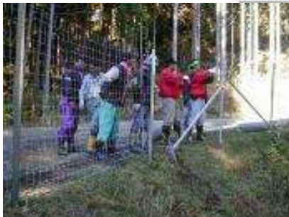
侵入防止柵の設置
