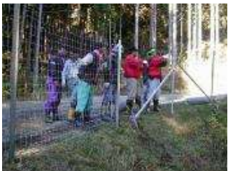
侵入防止柵の設置
