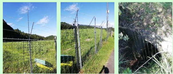
地域に適合した複合柵、門扉、水路の暖簾式ゲート
