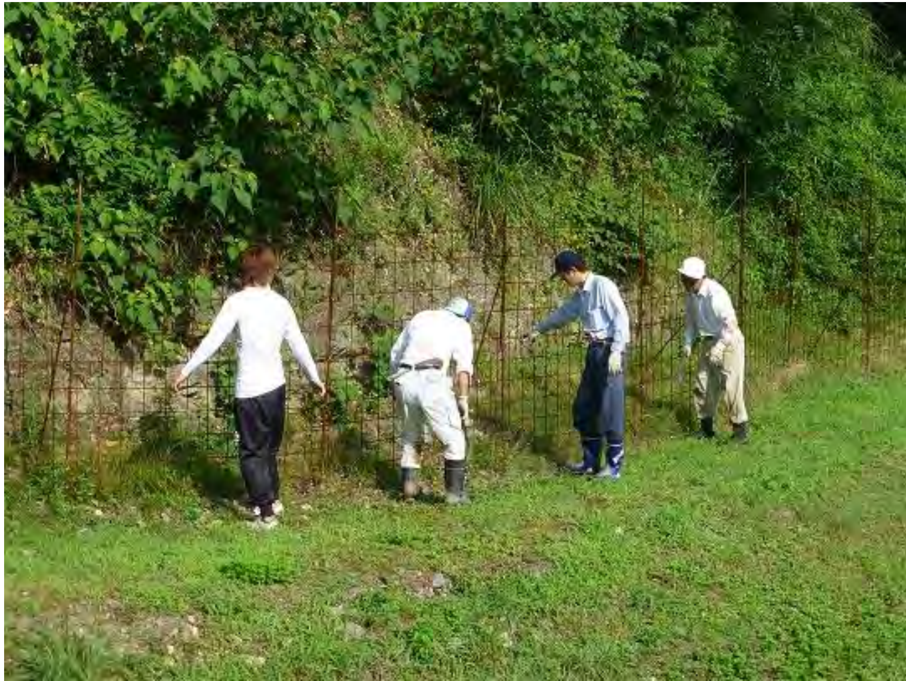
設置したWM柵は地域で点検
