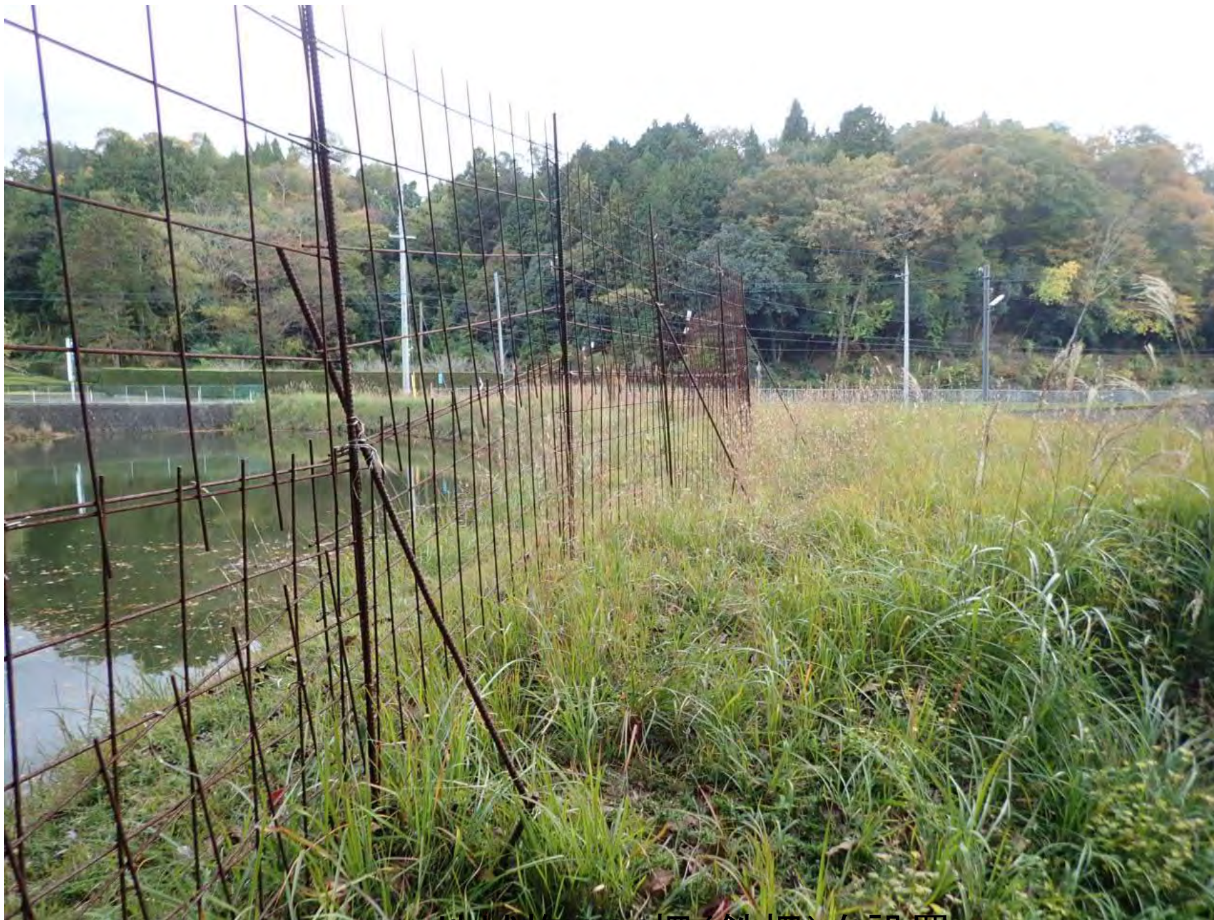
地域施WM柵(鉄柵)を設置
