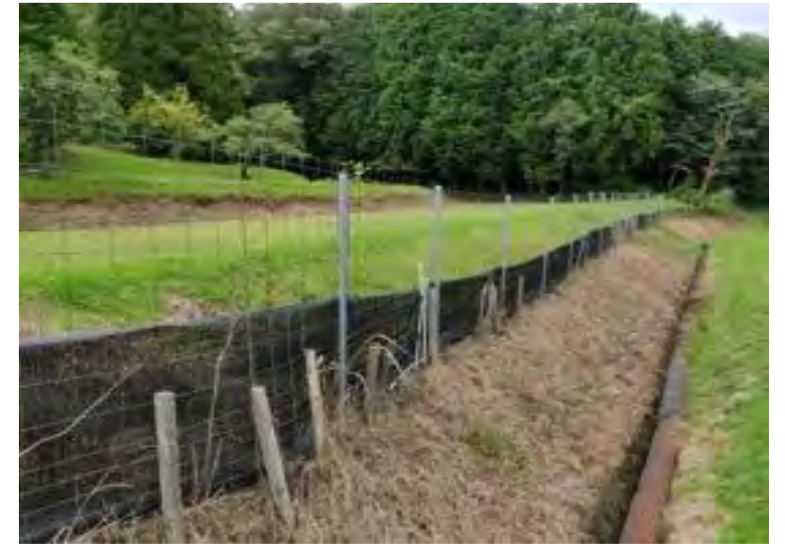
防草シートを用いた目隠しの設置
