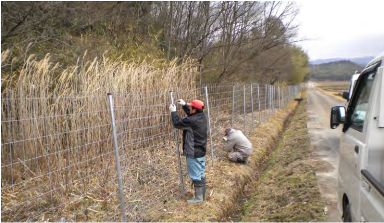
防護柵被害カ所と補修作業
