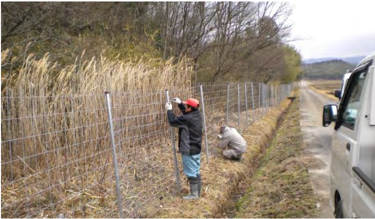
防護柵被害カ所と補修作業
